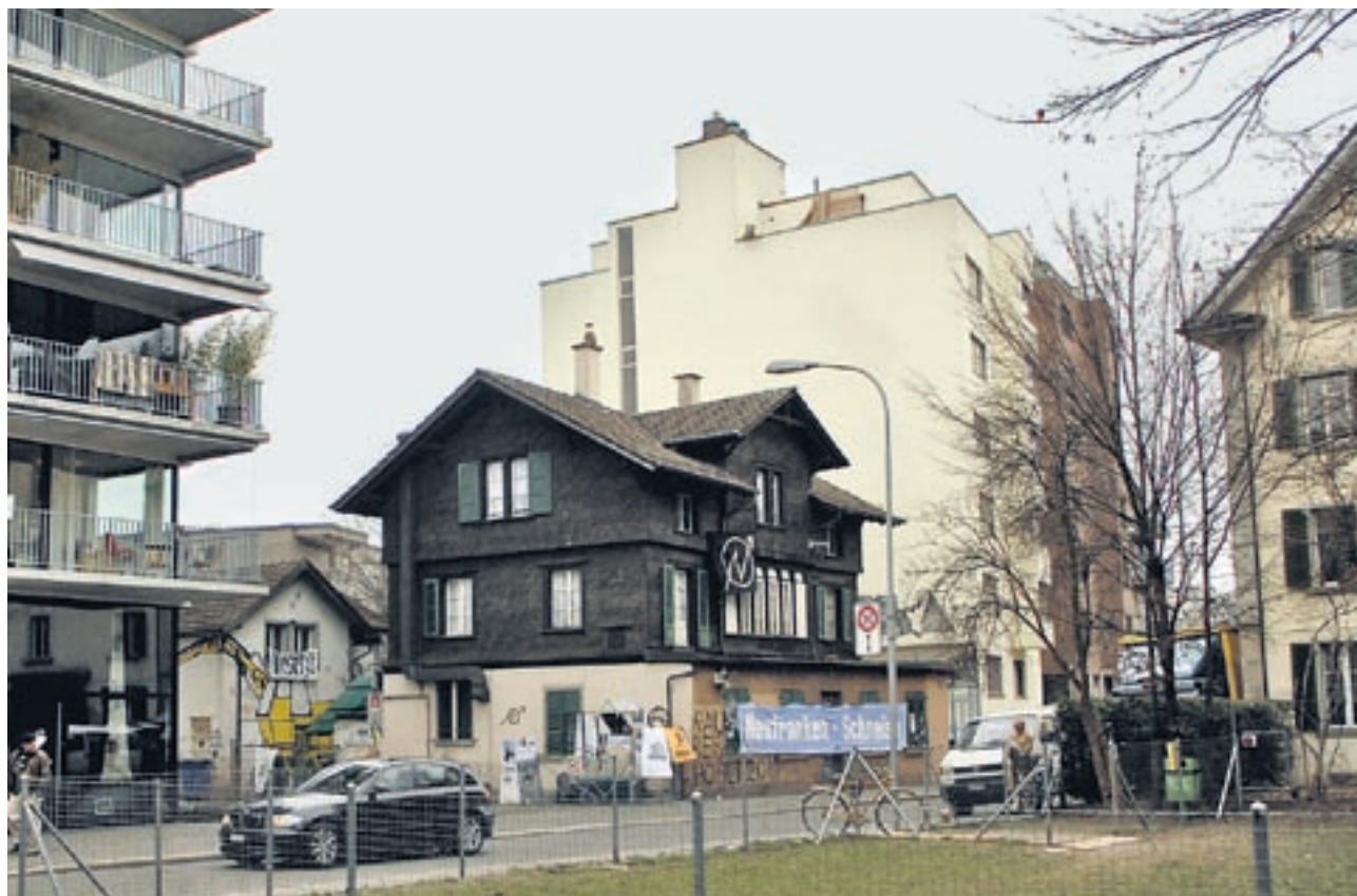
Das Gebäude (Bildmitte) an der Neufrankengasse ist dem Untergang geweiht. Bis Ende Februar muss es abgerissen sein. Bild: wue
