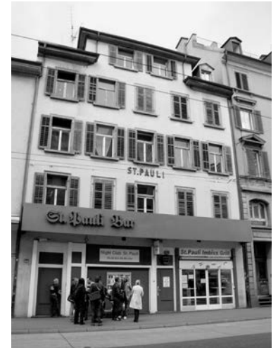
Das Haus von 1892 vor dem Umbau.
