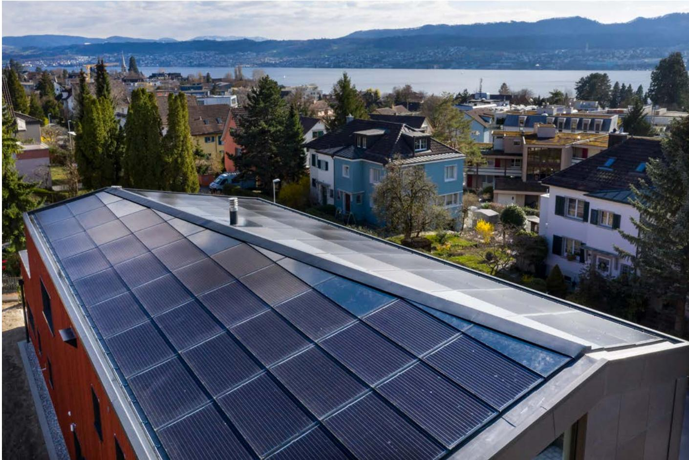
Vollintegriertes PV-Dach mit leicht abgedrehtem First und Firstkönig.
